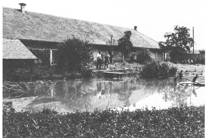
Fig. 2 Öko-Ethologische Station zur Erforschung der Pflanzen- und Tierwelt in den Stauräumen der Kraftwerke
