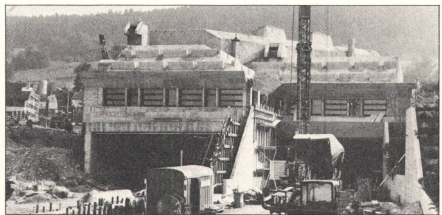
Tunnel-Rohbau Seite Weiningen mit später bepflanzttem Lärmschutzwall
