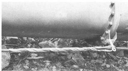
Fig. 4 Endabspannung des Luftkabels
