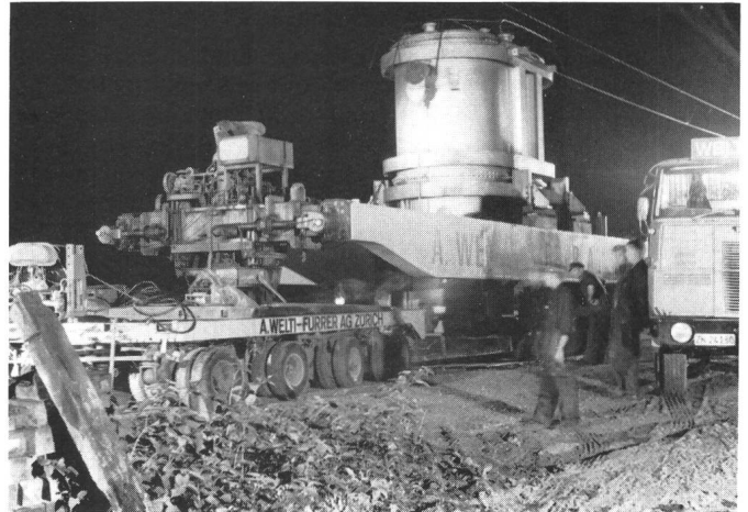
Wegfahrt eines von der Bahn auf die Strasse umgesetzten Transformators. Gut ersichtlich ist am vorderen Ende des Tragrahmens die motorhydraulische Hebevorrichtung des Tragrahmens.
