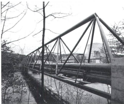
Fig. 11 Beidseits vom neuen Fussgängersteg sind die Vorlauf- und Rücklaufleitungen für die Fernwärme montiert.
