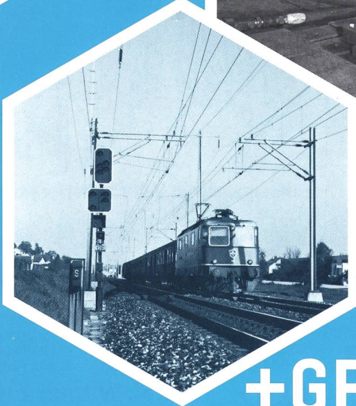
Fahr- leitungs- bau ▶
