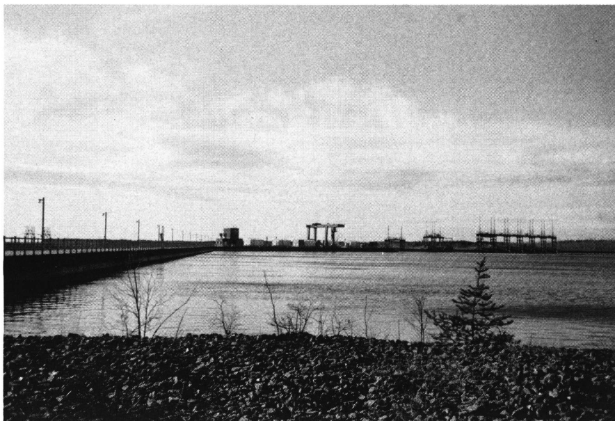
Fig. 2 Stausee und Kraftwerk Chute à la Savane
