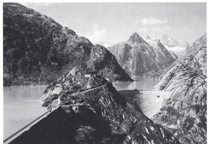
Fig. 2 Die heutige Stauanlage Grimsel
