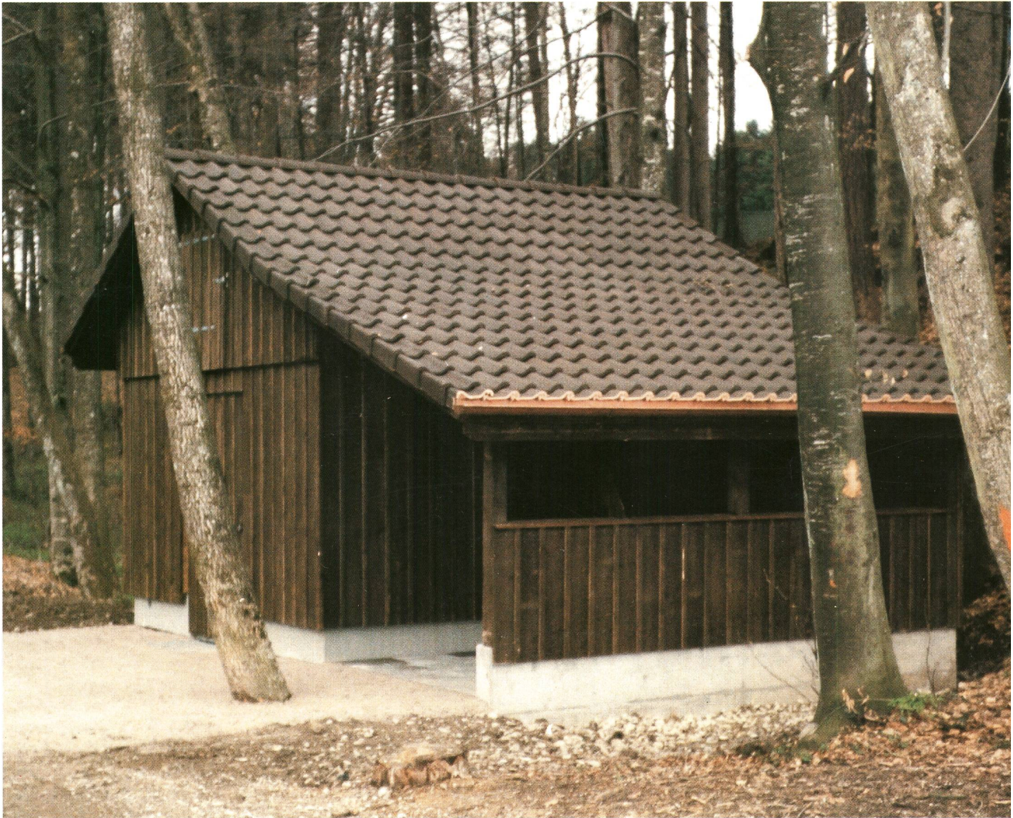
Überflur-Trafostation Typ A Anlage «Grunau» Erstellungsjahr 1985
