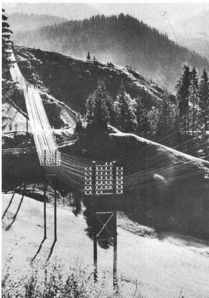
Figur 5 Doppeldrahtleitung
