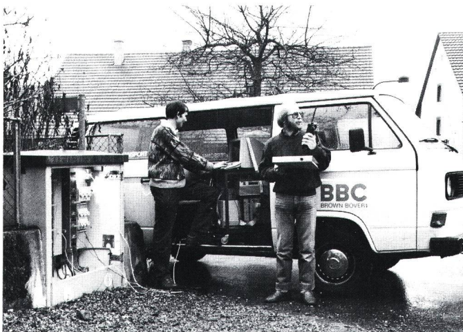
Figur 9 Messungen in einem 220-V-Netz. Fahrbare Messstation
