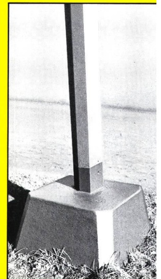
Betonsschutz an Mastsockeln
