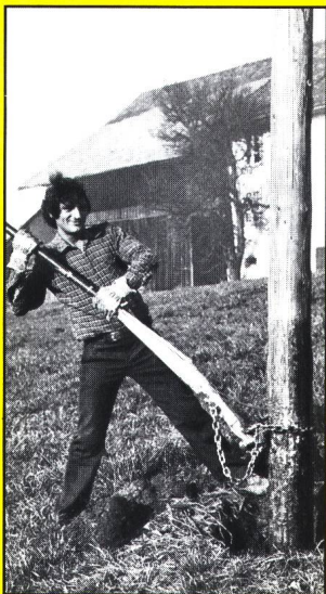
Nachimprägnierung von Holzmasten
