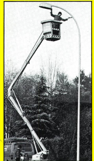
Korrosionsschutz an Stahlkandelabern
