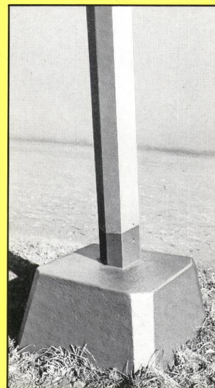
Betonsschutz an Mastsockeln
