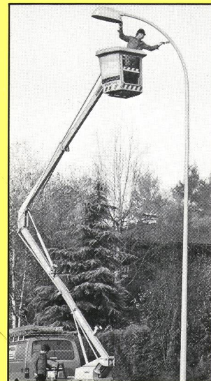
Korrosionsschutz an Stahlkandelabern
