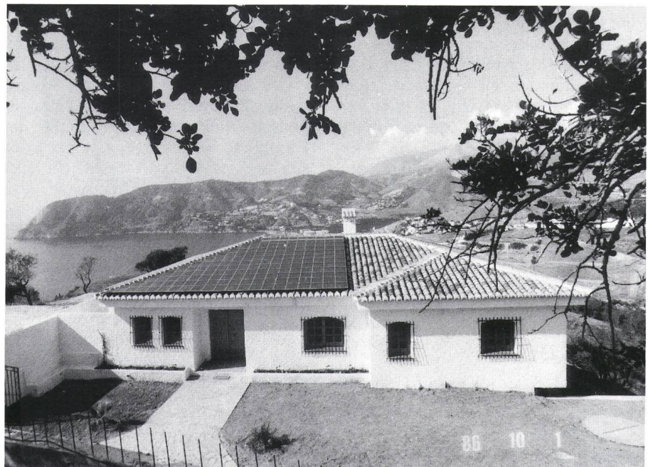
Figur 1 Ein typisches Haus an Spaniens Südküste. Trotz der Verwendung der dort üblichen Rundziegel wirkt der von First bis Traufe durchgehende PV-Generator nicht als Fremdkörper. Auch dieser Generator ist auf das Ziegeldach aufgesetzt.
