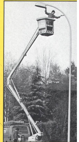
Korrosionsschutz an Stahlkandelabern
