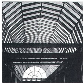
Hochbaukonstruktion (Unternehmensbereich Stahlbau)
