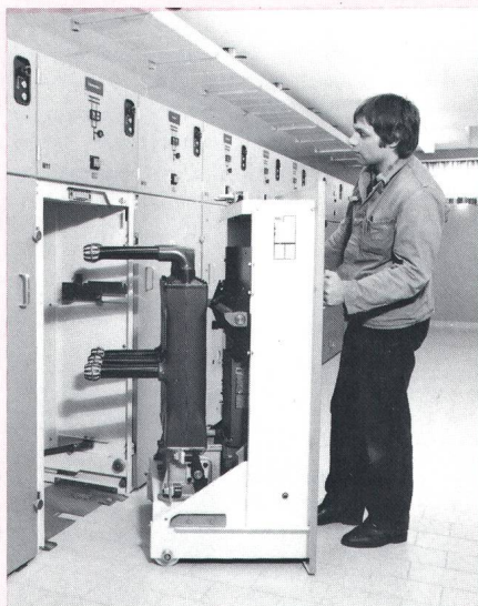
Gasisolierter Schalter in Kompaktausführung
