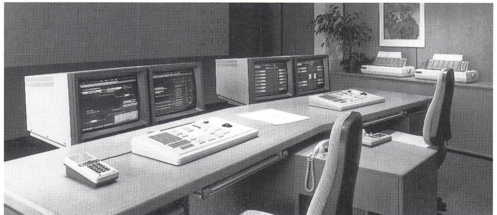
TELEGYR-Netzleitstelle des EWN Stans
