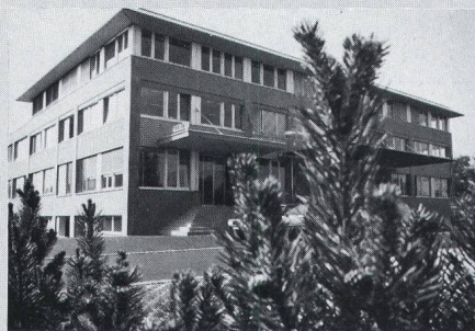
Neubau mit optimalen Arbeitsbedingungen
