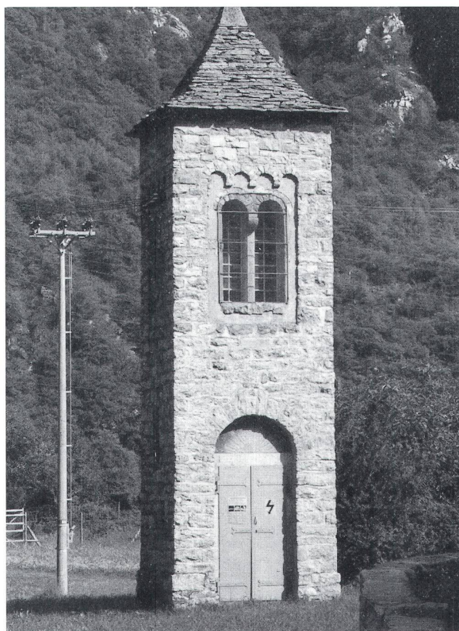
Figura 2 L'architettura della cabina di trasformazione della Società Elettrica Sopracenerina nella frazione di Motto è stata evidentemente influenzata dalla vicina chiesetta romanica.
