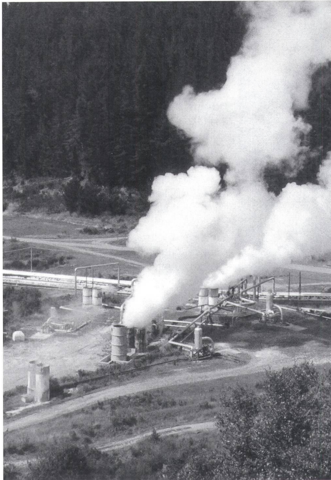
Bild 1 Geothermische Kraftwerke haben einen enormen Flächenbedarf. Wasser und Dampf aus dem Innern der Erde gelangen in kilometerlangen Pipelines vom geothermischen Feld zur Zentrale, die sich in der Nähe eines Flusses befinden muss.
