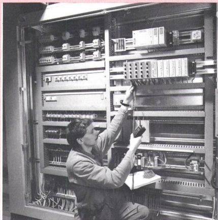
Arbeiten an einer Grossverteilanlage
