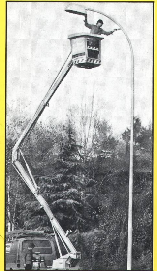
Korrosionsschutz an Stahlkandelabern
