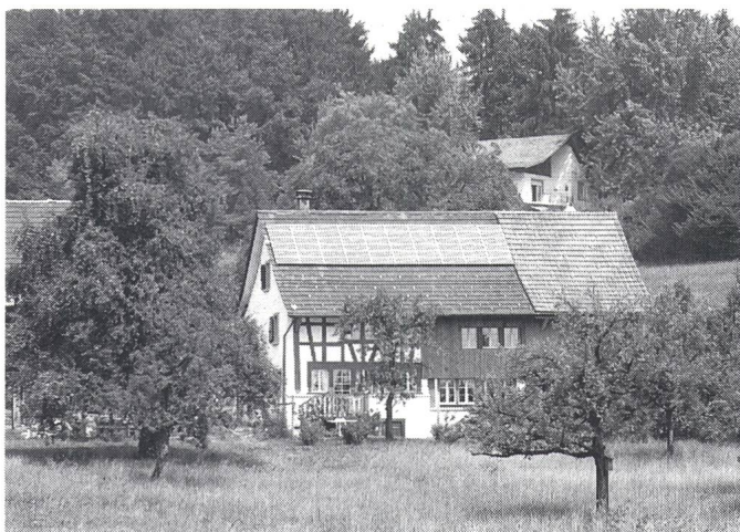
Eine 3-kW-Solaranlage aus dem Projekt Megawatt
