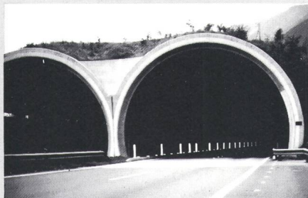
Mötz-Galerien: Reflektoren statt Tunnelbeleuchtung
