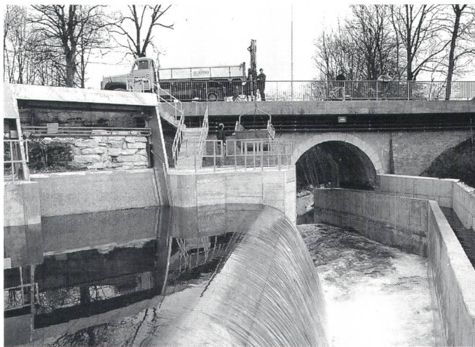
Das Kleinwasserkraftwerk Roggwil, im Kanton Bern, hat eine installierte Leistung von 250 kW. Dies entspricht etwa 10% des maximalen Leistungsbedarfs der Gemeinde Roggwil
