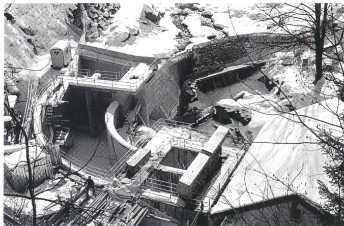
Im «Herrentöbeli» bei Krummenau entstand unter schwierigen Bedingungen ein neues Kleinwasserkraftwerk
