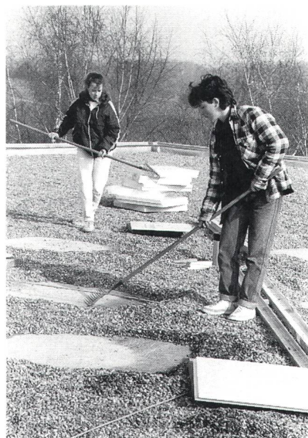
Bild 2 Schüler und Schülerinnen bereiten das Dach für die Montage der PV-Anlage vor
