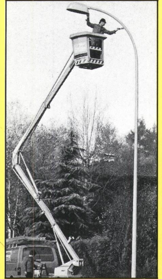
Korrosionsschutz an Stahlkandelabern
