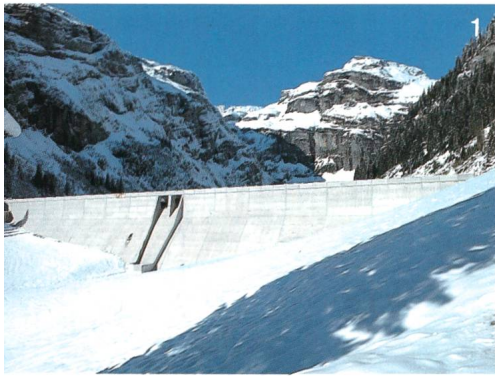
1 Die Staumauer des Panixersees der Kraftwerke Ilanz (Graubünden) konnte 1990 vollendet werden. Ab 1992 wird sie 7,2 Mio. Kubikmeter Wasser zurückhalten.
