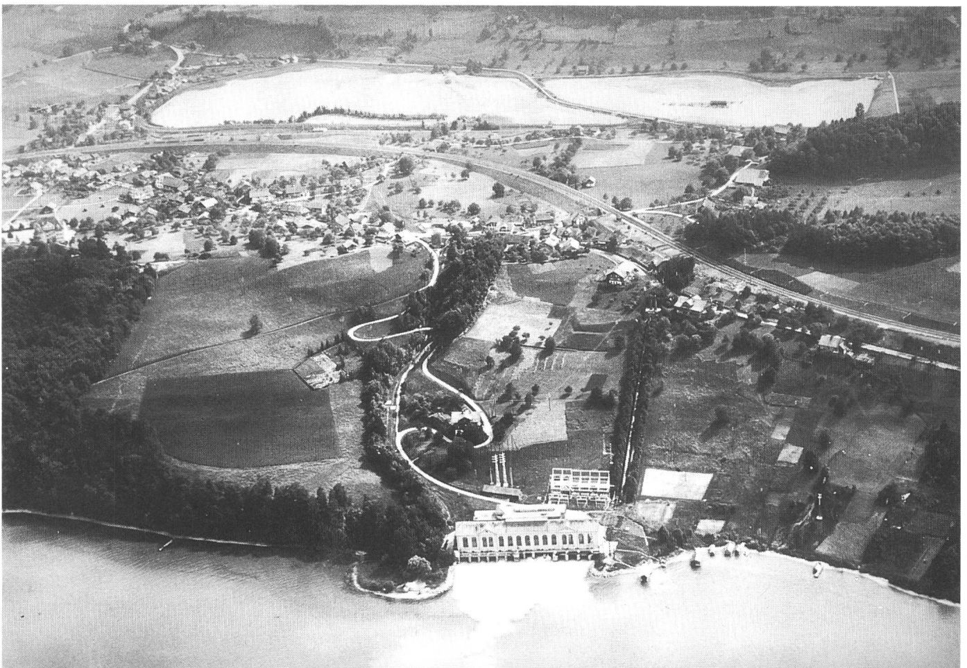
Bild 19 Luftaufnahme des Speicherkraftwerkes Spiez am Thunersee mit Tagesspeicher Spiezmoos
