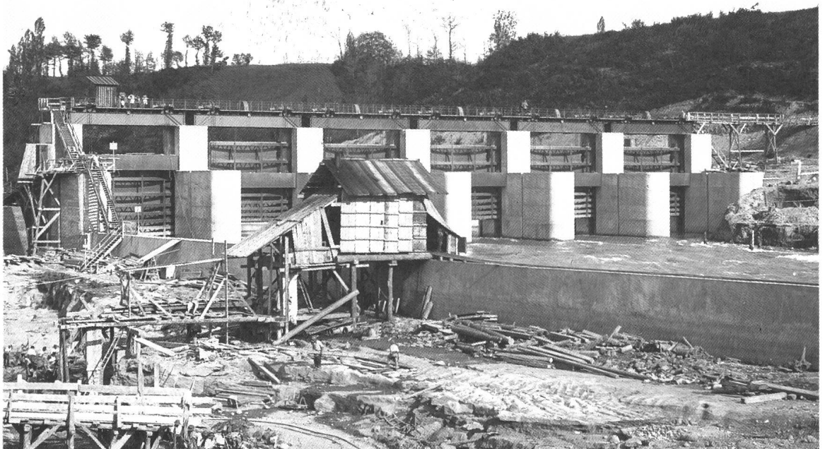
Bild 15 Unterwasserseitige Ansicht (1894) des Wehres Chèvres an der Rhone unterhalb von Genf Im Vordergrund die Baugrube für das Maschinenhaus
