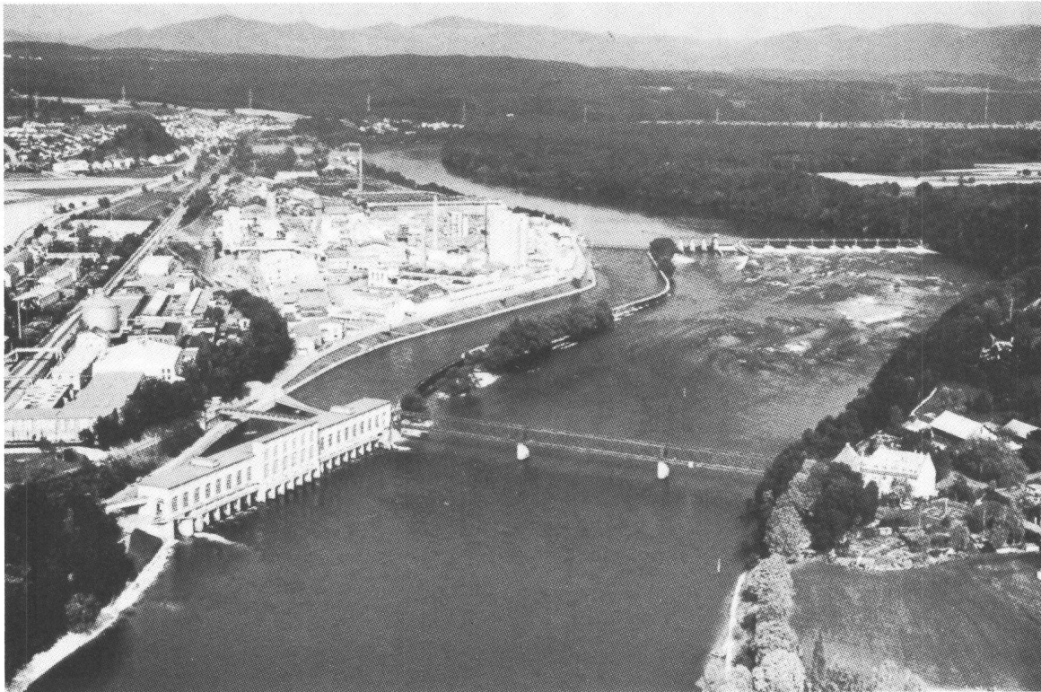
Bild 16 Modernere Luftaufnahme des Niederdruckkraftwerkes Rheinfelden Foto: Elektrowatt, Zürich
