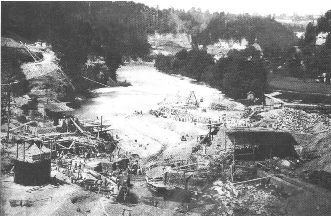
Bild 11 Baustelle der Stau- mauer Péroilles vom Oberwasser Foto: Entreprises Electriques Fribourgeoises, Fribourg
