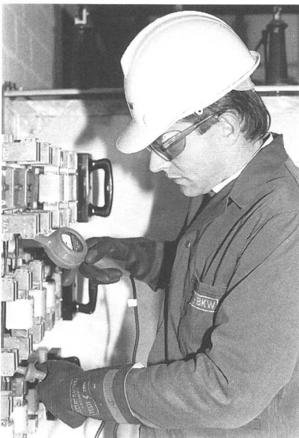
Bild 6 Grundausrüstung «Persönlicher Schutz»
