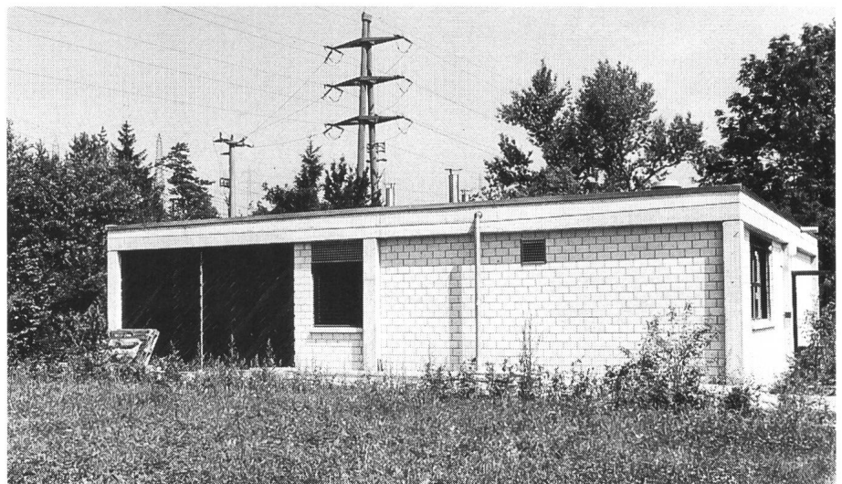
Bild 1 Wasserstoff- und Brennstoffzellen-Anlage in Niedergösgen
