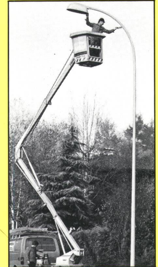
Korrosionsschutz an Stahlkandelabern
