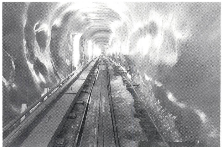
Bild 4 Eisstollen im 48 \text{ m} dicken Eis
