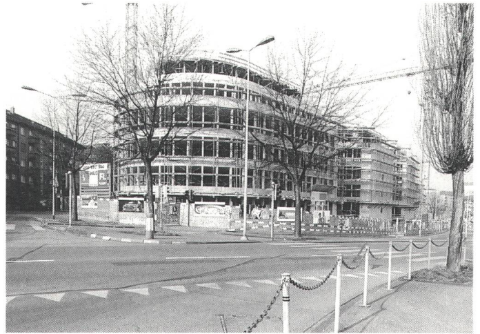
Ansicht des Rohbaus von der Kreuzung Tram-/Dörflistrasse her
