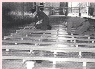
GFK-Gitterroste sind leicht zu verlegen
