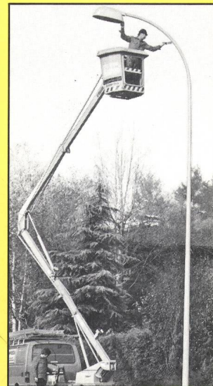
Korrosionsschutz an Stahlkandelabern
