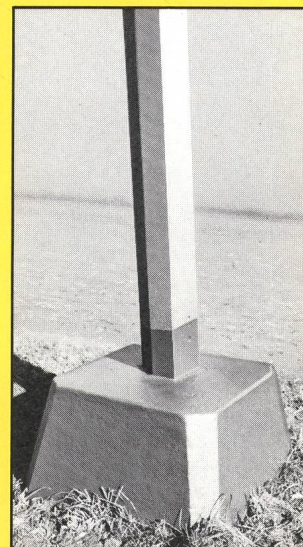
Betonschutz an Mastsockeln
