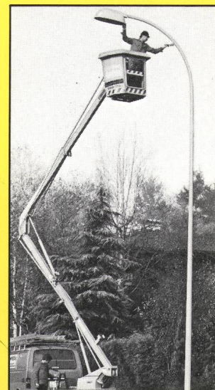
Korrosionsschutz an Stahlkandelabern
