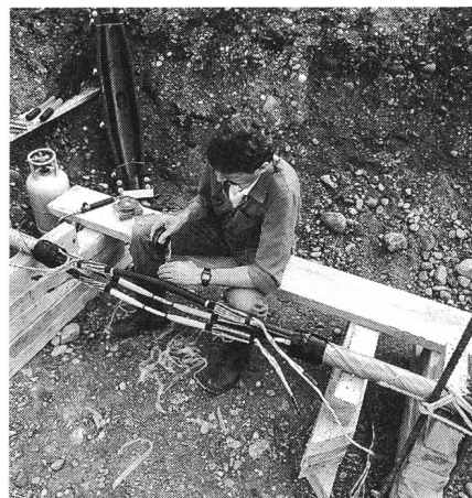
Bild 8 Muffenmontage mit Wickeltechnik
