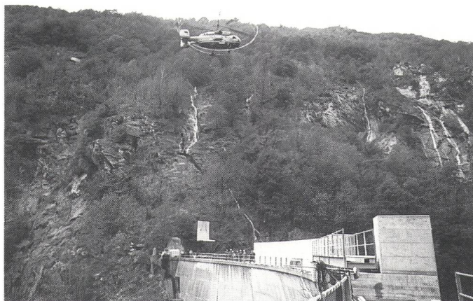
Bild: Abliegung eines der 35 L-förmigen Elemente (4,3 Tonnen) auf der Krone der Staumauer Vasasca Foto: Posa di uno dei 35 elementi a «L» del peso di circa 4,3 t sulla corona della diga Vasasca (Foto: Massimo Pedrazzini)
