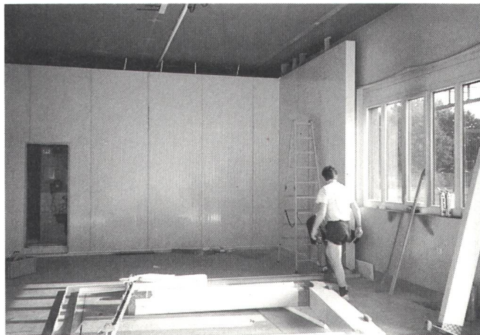
Bild 3 Die Klimazelle im Aufbau. Bis auf wenige Zentimeter wird der gesamte bisherige Garagenraum beansprucht
