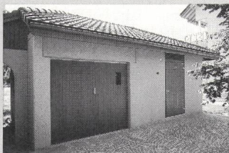
Trafostation mit Anbau
