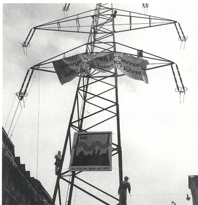
Ein 50 Meter hoher Hochspannungsmast mitten in Zürich, der sich erst noch zum Tauklettern eignet Un pylône pour lignes à haute tension de 50 mètres en plein cœur de Zurich, de quoi attirer les alpinistes les plus téméraires
