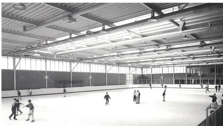
Bild 1 Für gutes Eis und trockene Luft in dieser Eiskunstlaufhalle sorgt eine Kälteanlage mit ungefähr 500 Kilowatt Leistungsaufnahme. Das Kühlmittel verdampft direkt in den kilometerlangen Stahlrohren, die im Beton unter der Eisfläche liegen
