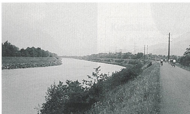
Fünf Staustufen sollen hier am Rhein die regionale Stromversorgung sichern
