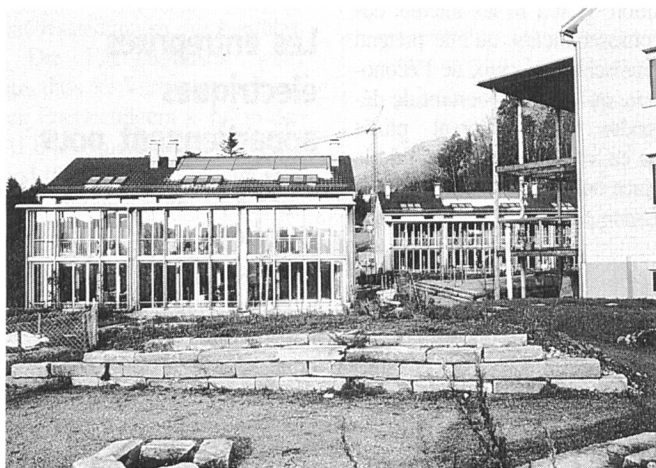
In Zukunft weniger Probleme für erneuerbare Energien in Gesetzen und Verordnungen? Diese Überbauung in Wald (ZH) wurde kürzlich mit dem SIA-Energiepreis 1992 ausgezeichnet (Foto H. Hobi)
