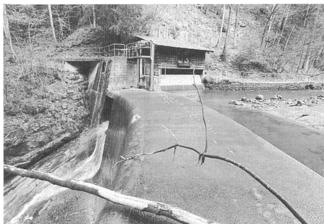
Wasserfassung Achmühle: Wander-Ausgangspunkt zum Kleinwasserkraftwerk Lochmühle
