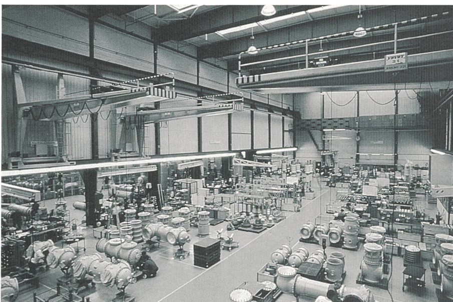
Bild 7 Montage einer gasisolierten Schaltanlage
