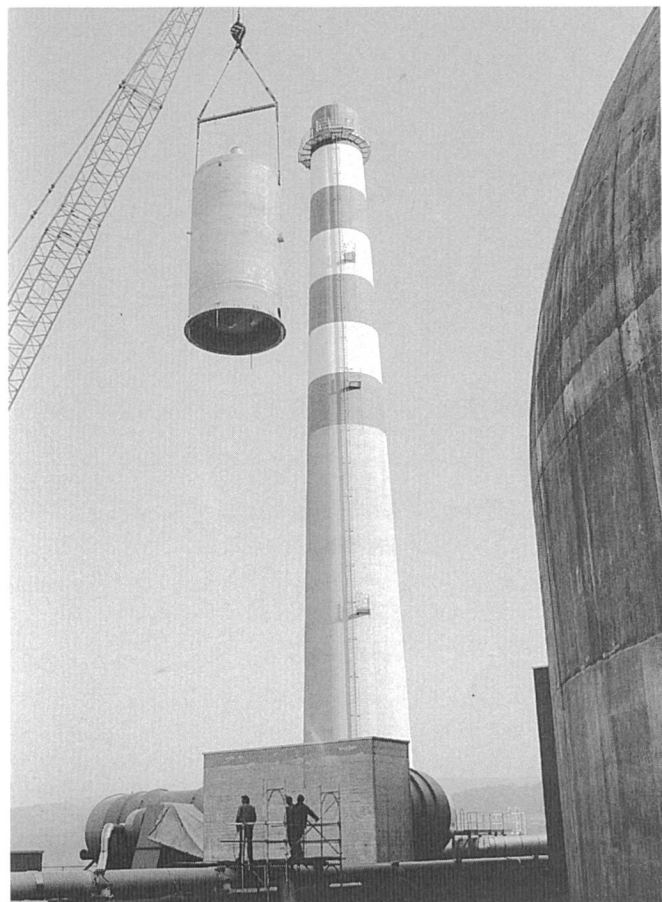
Die Filterbehälter wurden unmittelbar neben dem Abschirmgebäude abgesetzt. Ein Behälter wiegt 22 Tonnen
